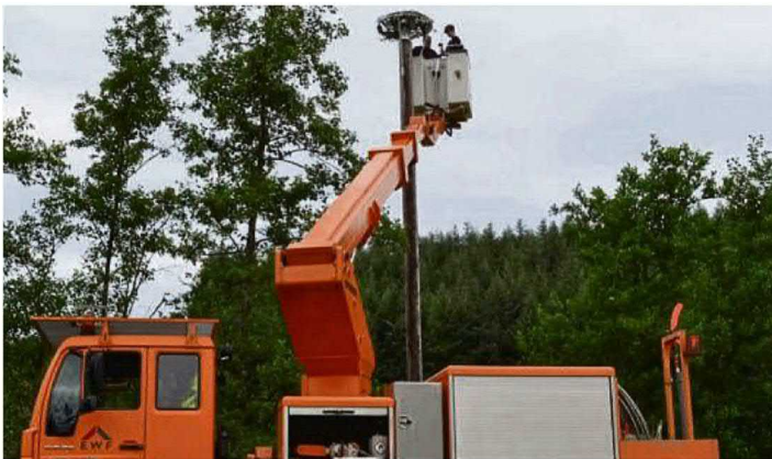
Einsatz in der Höhe: Sebastian Storch und Paul Grimm montieren die neue Nistplattform für Weißstörche im Aartal bei Münden.
