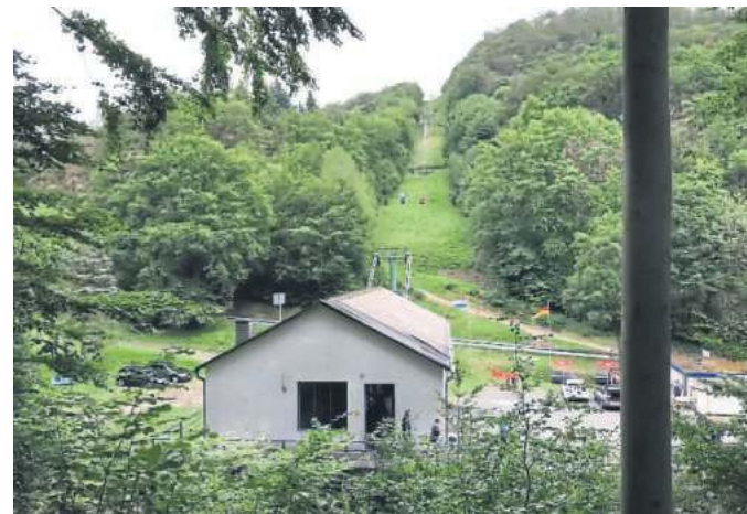
Breit: die Schneise für die bestehende Seilbahn, künftig Teil des Nationalparks..
