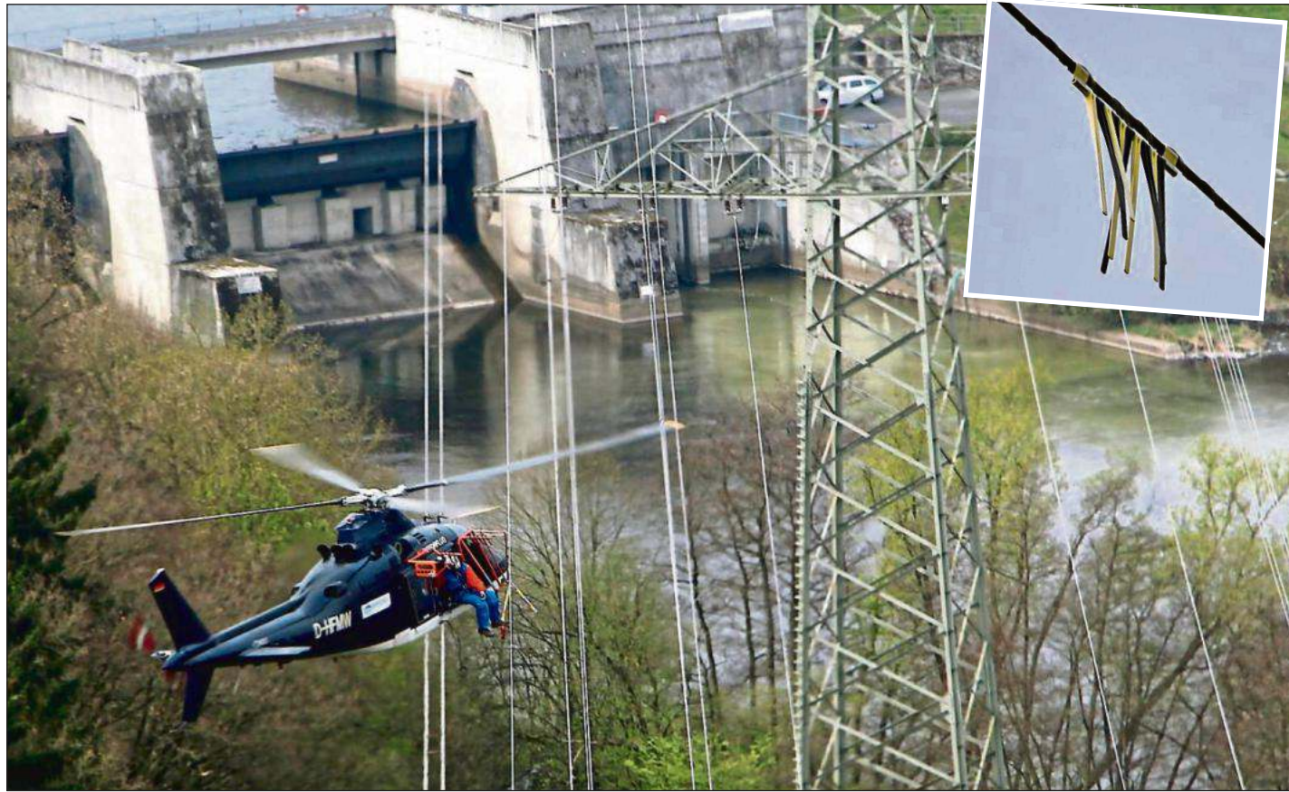
Das Gespann aus Pilot und Monteur bei der Arbeit am Affolderner See. Klein im Bild ein Vogelschutz-Element.
