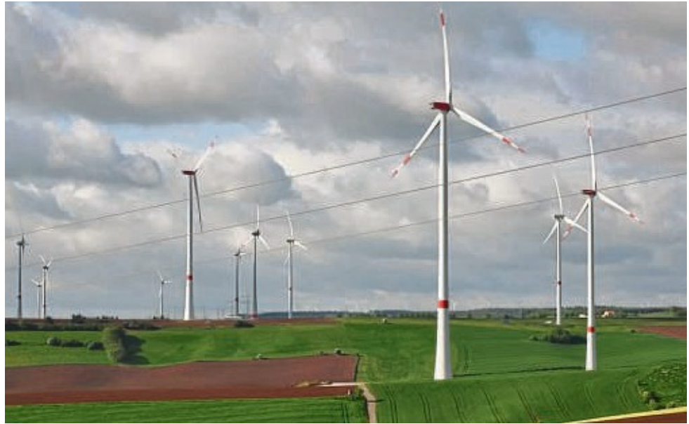
Häufung von Windkraftanlagen im waldeck-westfälischen Grenzgebiet: Der Windpark im Roten Land zwischen Neudorf, Helmighausen und Hesperinghausen. ARCHIVFOTO: SCHULTEN
