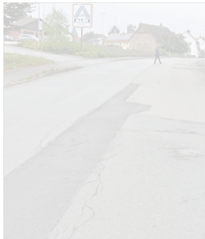
Vor einigen Jahren wurde die Landesstraße bereits in einem Abschnitt in Sachsenhausen ausgebaut, weitere drei Kilometer folgen nach Nieder-Werbe. Dazwischen bleibt ein 200 Meter langes Stück alter Fahrbahn.
