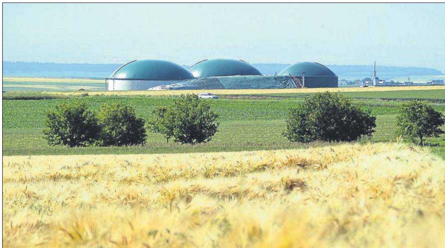
Biogasanlage: Eine solche Anlage – wie auf unserem Foto bei Niedenstein – sollte auch nahe der Burgwaldkaserne gebaut werden. Das Projekt ist jetzt endgültig vom Tisch: Der Bebauungsplan wurde vom Verwaltungsgerichtshof für unwirksam erklärt, eine Revision gegen das Urteil wurde nicht zugelassen. Das geht aus dem schriftlichen Urteil hervor.
