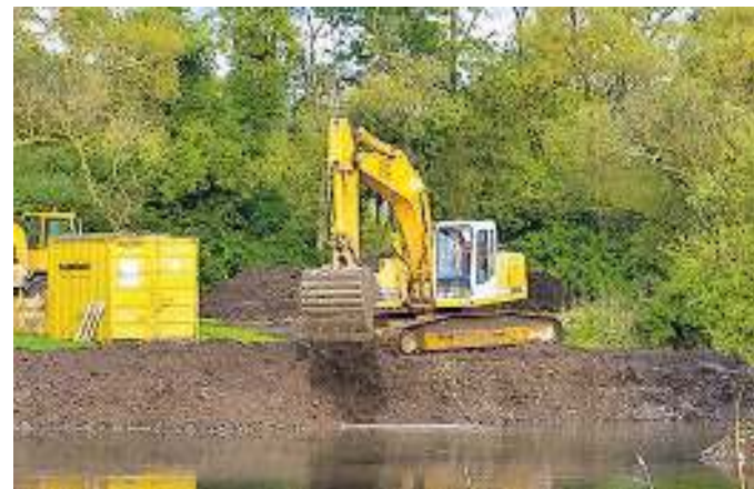
Die inzwischen abgeschlossenen Bauarbeiten zwischen den Brücken Anraff und Wega/Wellen. Foto: Sonderhuesken
