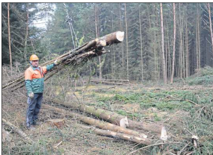
So war es: Das Forstamt hat auf einer 3,5-Hektar-Fläche die Nadelbäume zurückgenommen – mittels einer Seilkrananlage, die hier von Gabor Ioan von der Firma Hubert aus München bedient wird.
