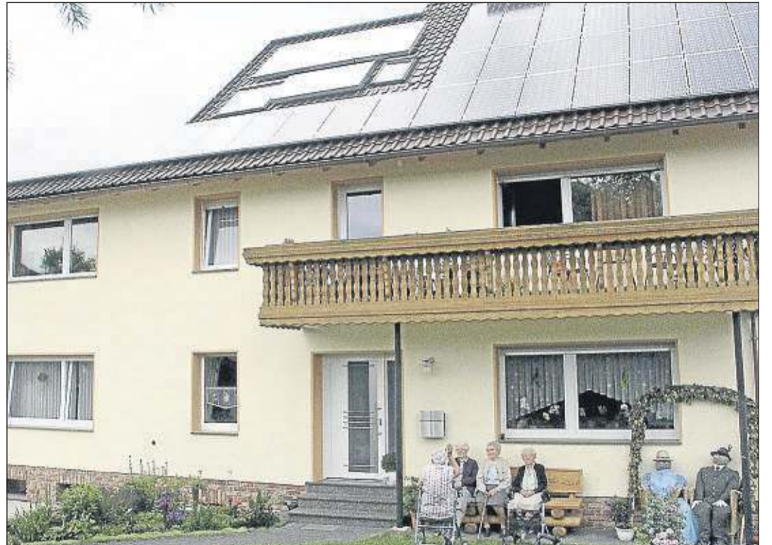
Heute: Bereits 1928 war das Haus aufgestockt worden und bis in die 1970er-Jahre befanden sich Stallungen für Kühe und Schweine im linken Teil. 2009 wurde noch mal modernisiert, Isolierung, Solartechnik, und große Fenster steigerten den Wohnwert. In der unteren Wohnung lebt das aktuelle Schützenkönigspaar Helga und Dieter Emde, oben wohnt Sohn Armin mit Familie. Zum Dorfjubiläum im Juni hatten Nachbarn das Königspaar als Strohuppen nachgebildet (ganz rechts) und freute sich bei einem Schwätzchen daran. (zut)
